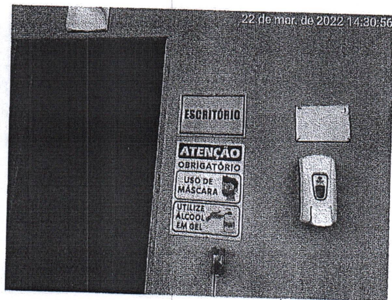
Local onde será feito os armários e divisórias para o vestiário feminino anexo ao
