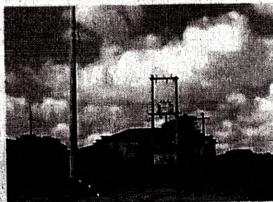
Rede trifásica na área da Fazenda
