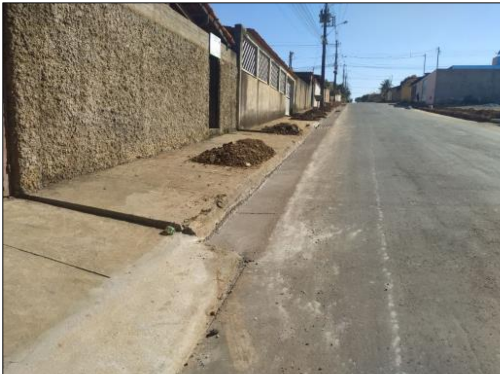
Figura 82 – Concretagem da sarjeta na Rua Araçuaí. Fonte: Relatório fotográfico medição nº 07/2022.
