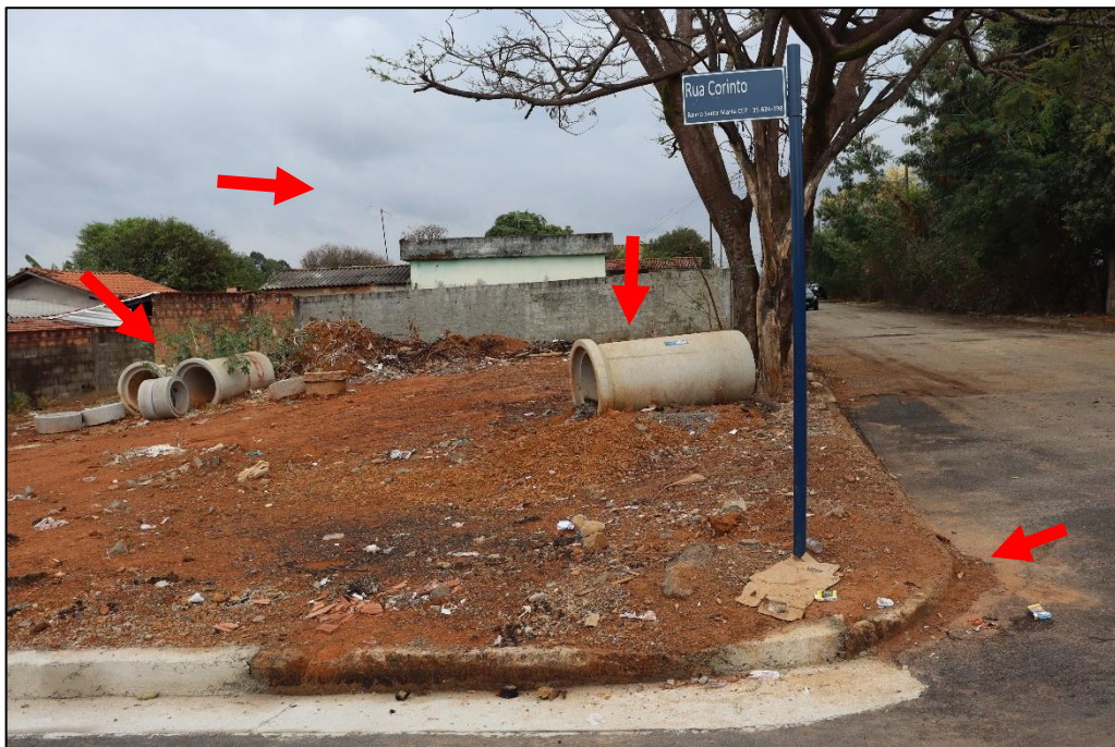
Figura 26 - Tubos de concreto para drenagem pluvial dispostos em terreno da rua Corinto, esquina com rua Jequitinhonha. Sinais de intervenção no meio-fio e descontinuidade da sarjeta.
