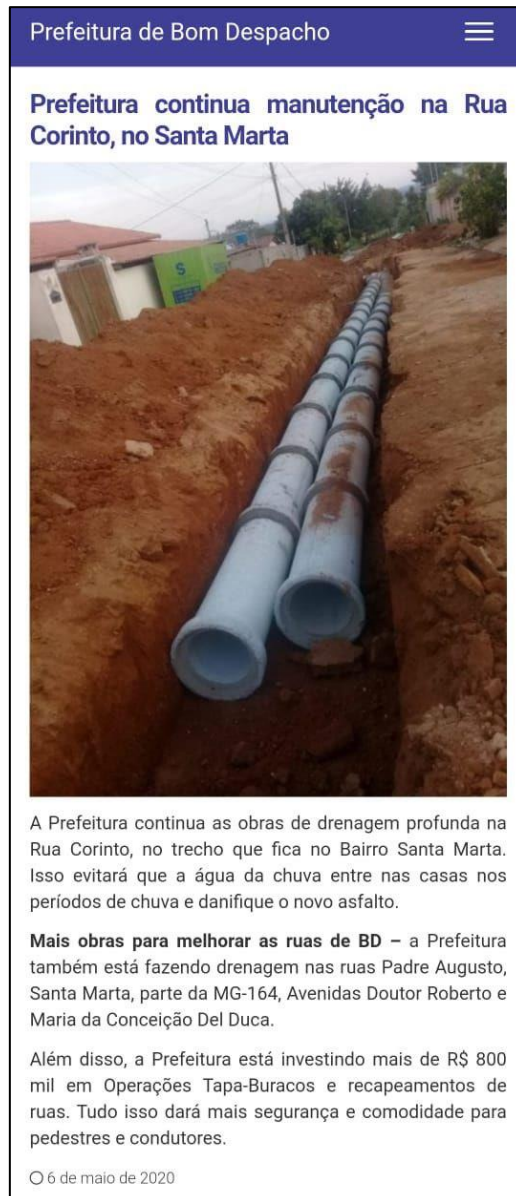
Figura 74 - Reportagem de 06/05/2020, a sequência das obras de drenagem pluvial da rua Corinto.
