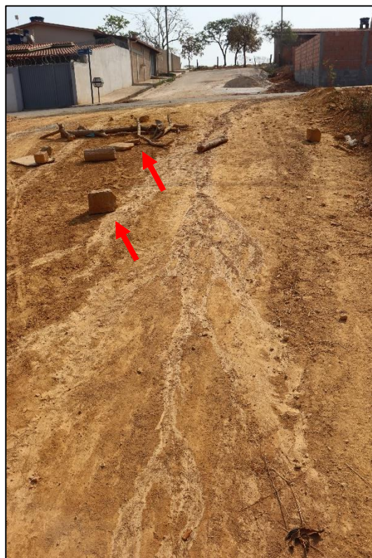
Figura 5 - Rua Almenara sem pavimentação, com a deposição de entulhos e galhos realizada pelos moradores, vista da esquina da rua Corinto.
