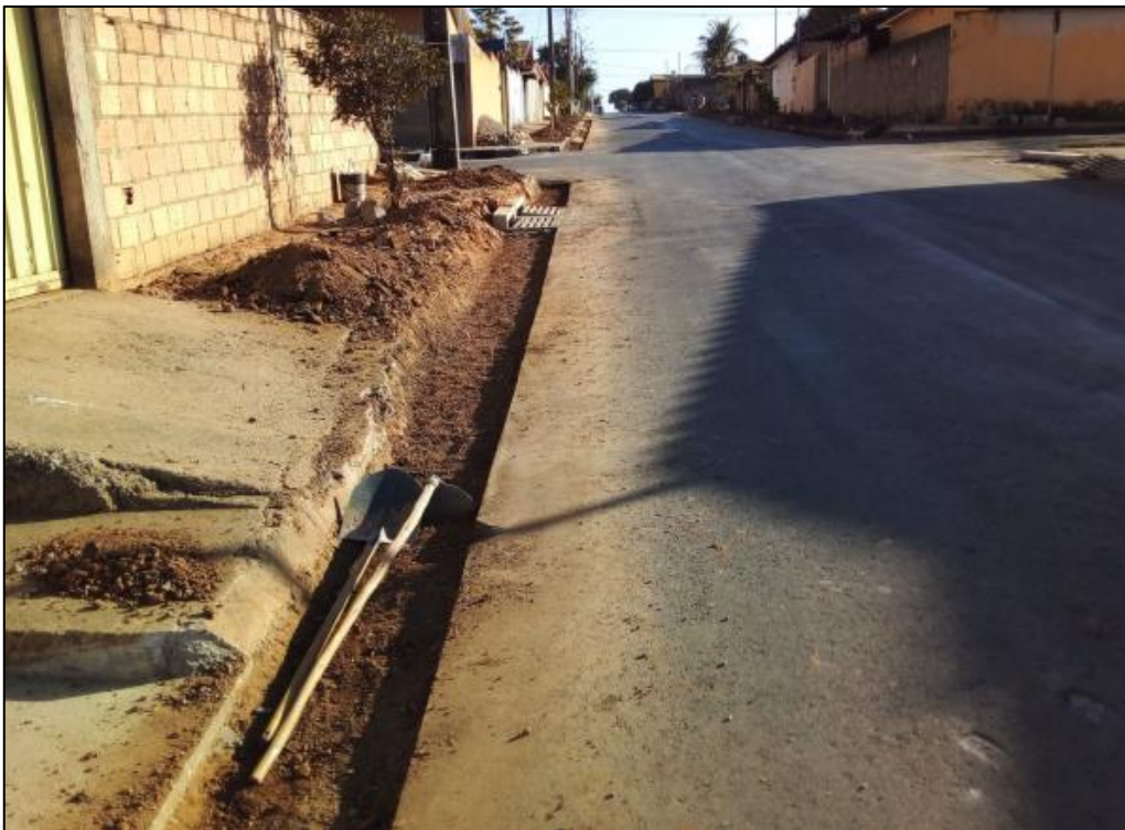
Figura 81 – Execução no corte do pavimento para sarjeta. Fonte: Relatório Fotográfico da Medição da empresa FFX.
