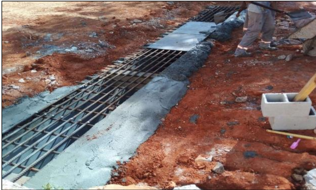
Figura 92 – Execução da fixação nas barras em concreto. Fonte: Relatório Fotográfico das medições da FFX.
