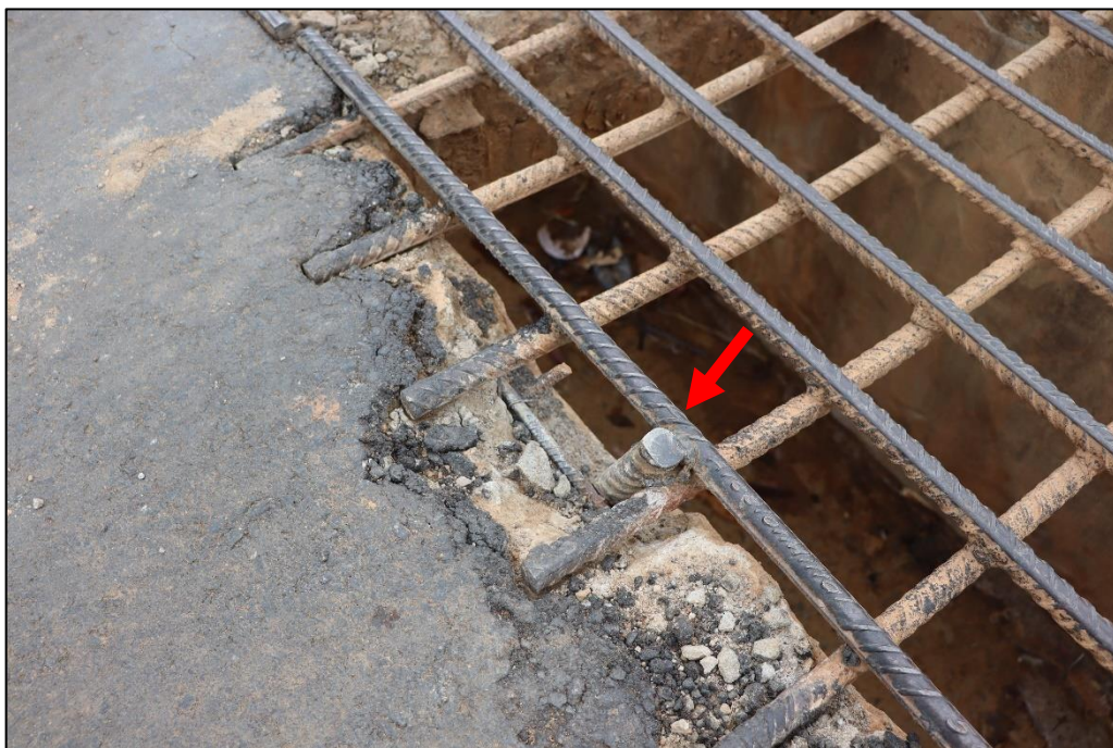
Figura 11 – Barra de aço ascendente da estrutura de borda da caixa de captação.
