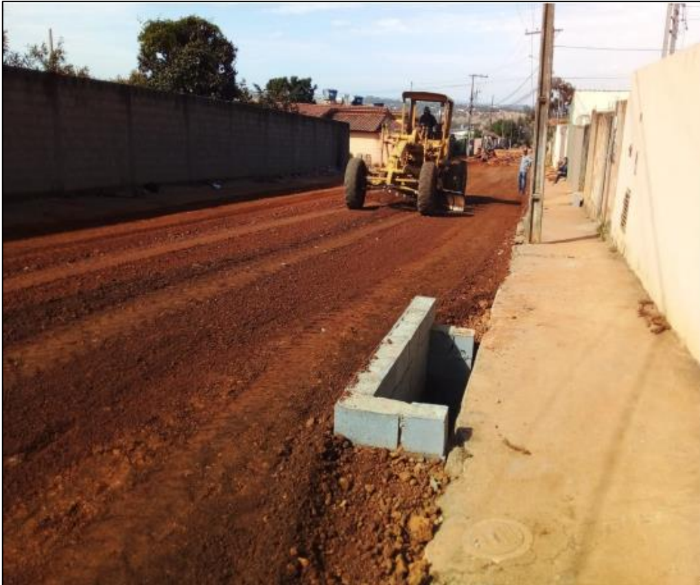
Figura 119 – Execução de tratamento de base. Fonte: relatório fotográfico das medições.
