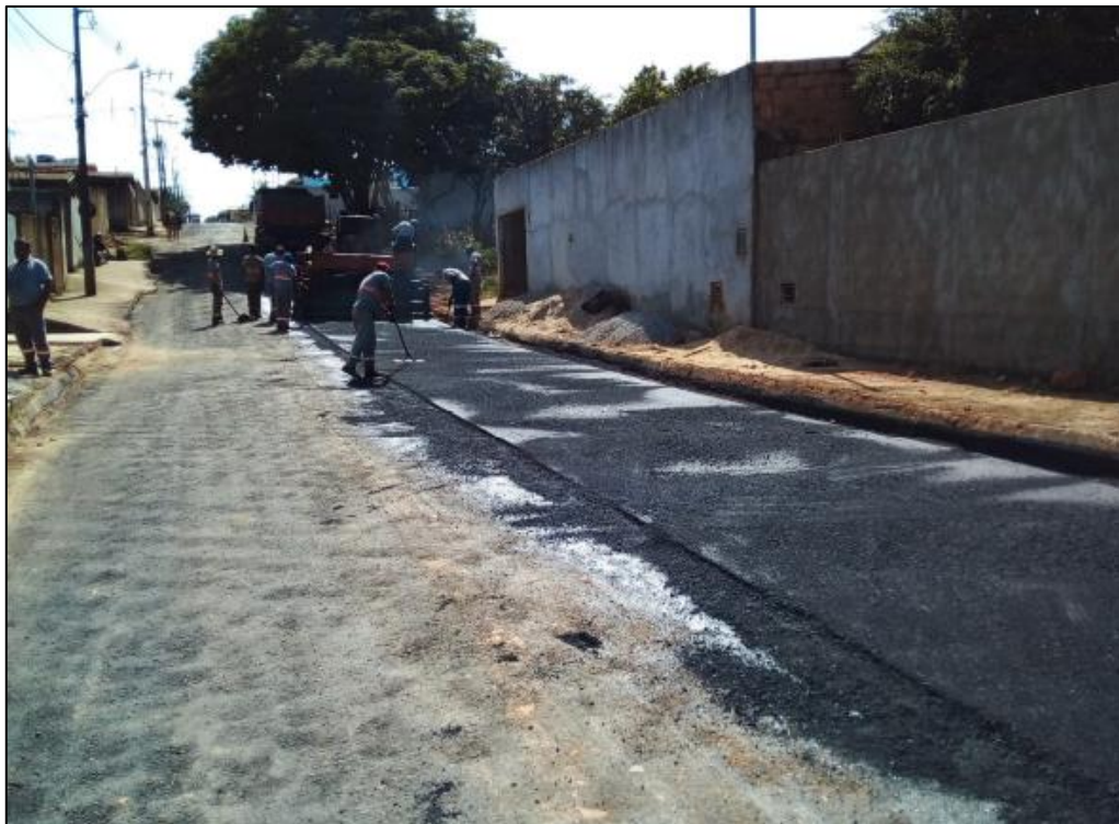
Figura 121 – Execução de pavimento na Rua Araçuaí sobre pavimento antigo e salgamento da via para maior durabilidade do asfalto. Fonte: Relatório Fotográfico das medições.
