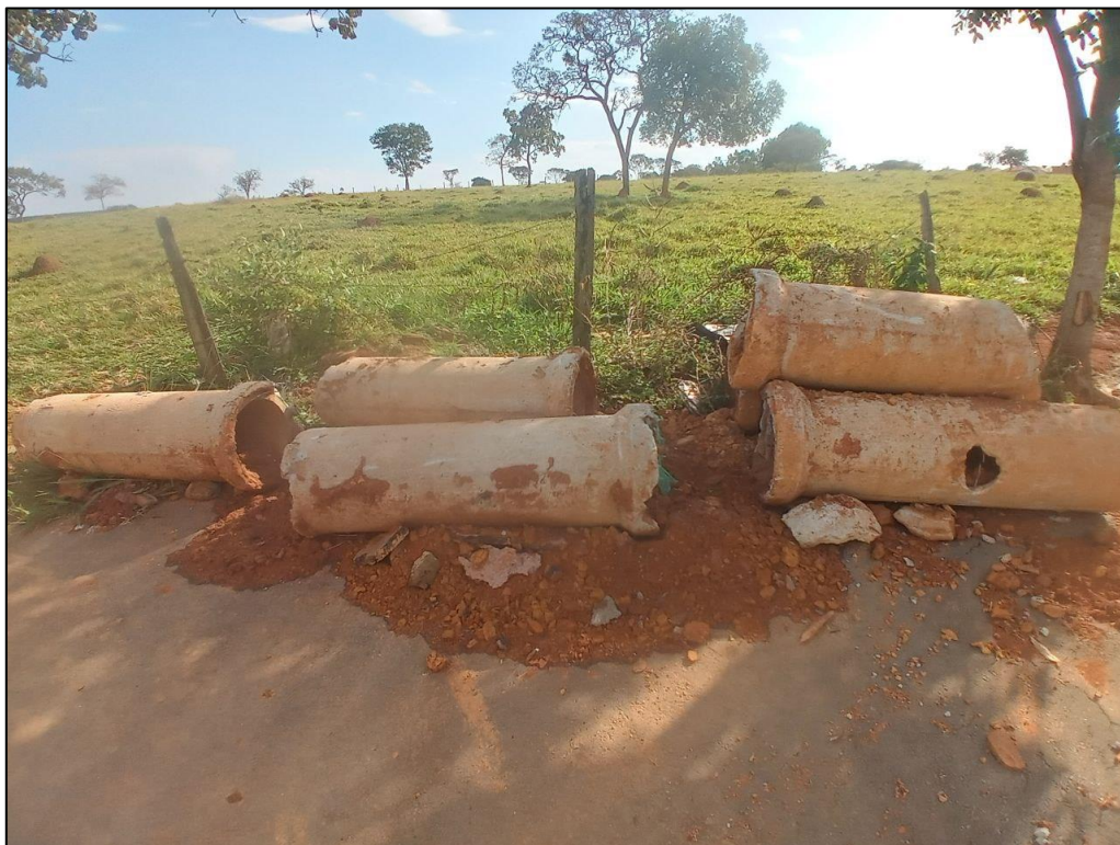
Figura 60 - Manilhas danificadas durante a remoção. Fonte: Fotografias capturadas pelo vereador Éder Tipura
