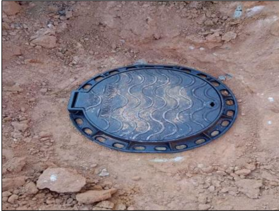
Figura 105 – Instalação dos tampões. Fonte: Relatório fotográfico das medições da FFX.
