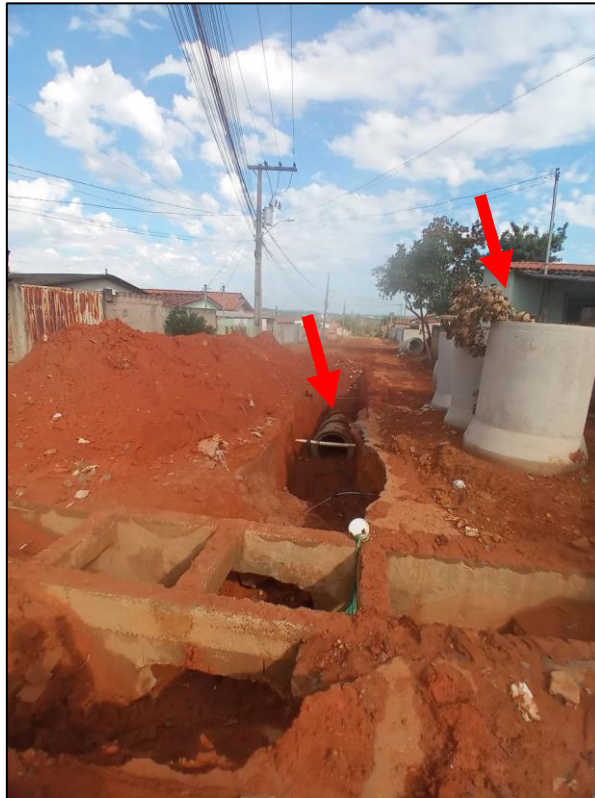
Figura 68 - Visualização da obra de manutenção da drenagem pluvial após as chuvas intensas.
