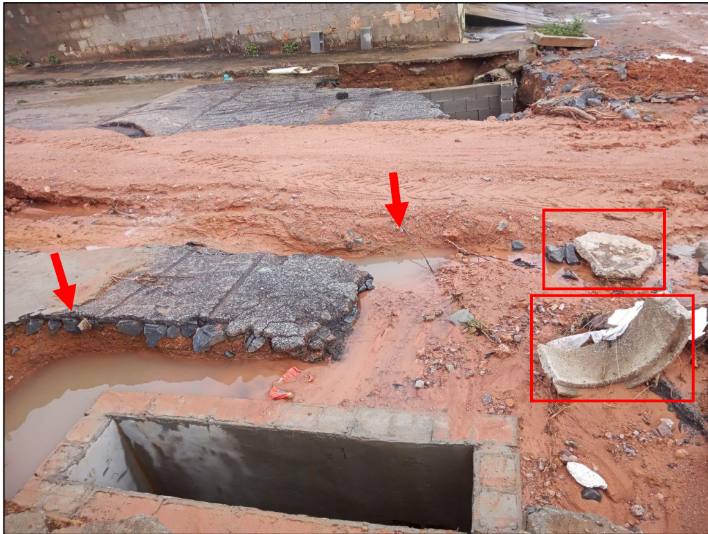
Figura 66 - Sequência da figura anterior. Fragmentos da tubulação de drenagem pluvial e empoçamentos na via. Novas caixas coletoras das bocas de lobo em execução.
