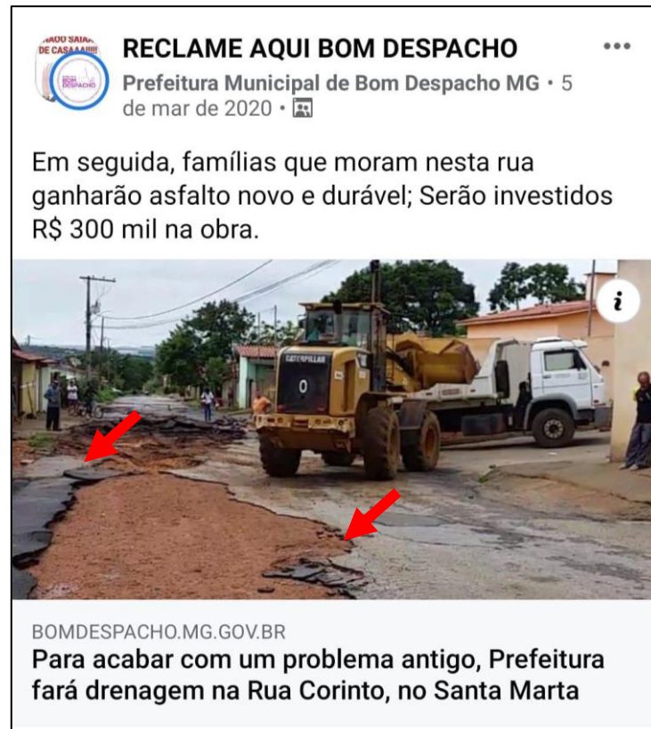
Figura 73 - Reportagem de 05/03/2020, anunciando o início de nova obra de pavimentação na rua Corinto. Observa-se distintas colorações na pavimentação na via, expondo as camadas do revestimento.
