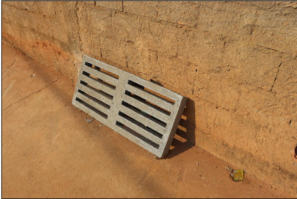
Figura 8 - Grelha de boca de lobo em concreto disposta no passeio.
