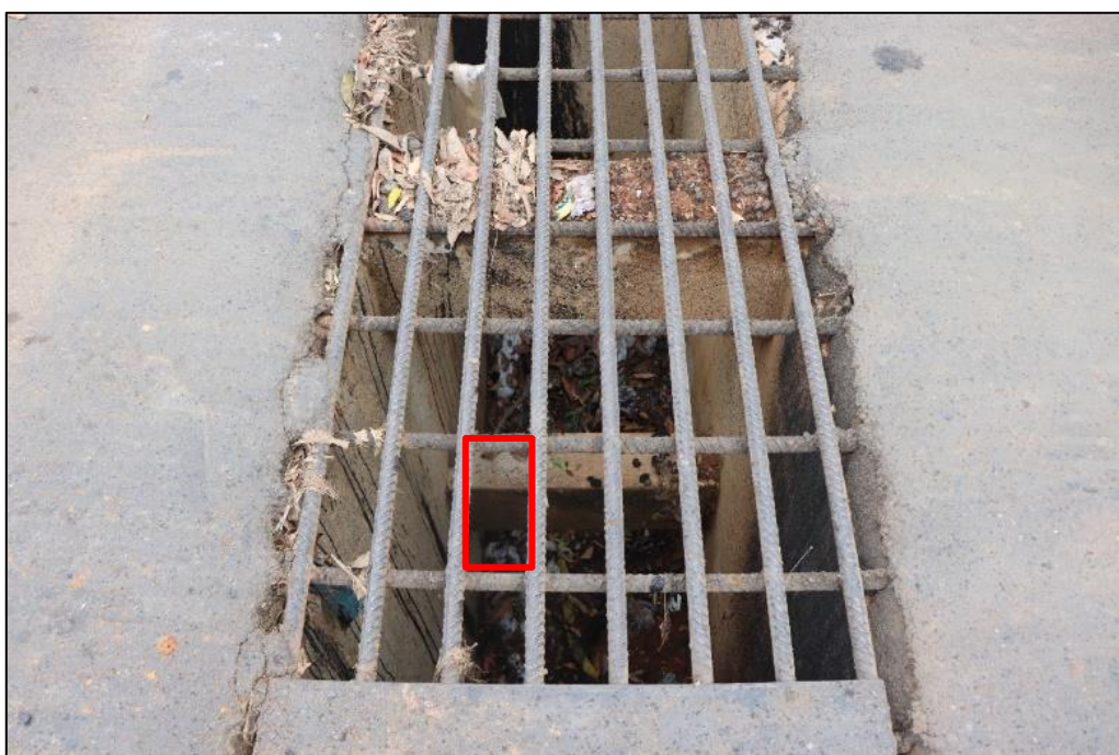
Figura 94 – Dimensionamento da grelha com vergalhão de Ø 25mm. Destaque para a abertura entre barras permitindo a passagem de um pé humano ou de algum animal de médio porte. Imagens da diligência de 22 de setembro.
