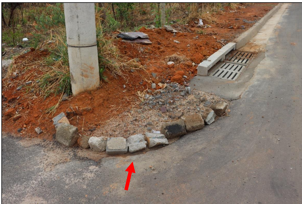
Figura 48 - Pedras usadas na contenção de solo onde não há meio-fio.
