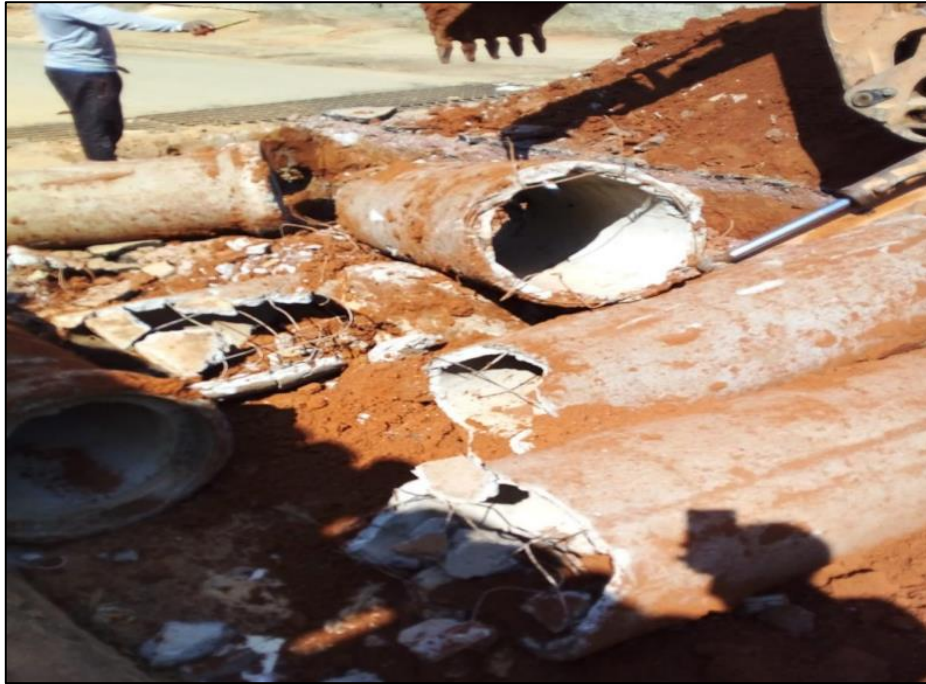
Figura 53 – Demolição e remoção da primeira drenagem pluvial da rua Corinto. A imagem indica que parte dos materiais da primeira drenagem não foram reaproveitados. Fonte: relatório fotográfico da primeira medição da adesão 09/2021 em 08/09/2021.
