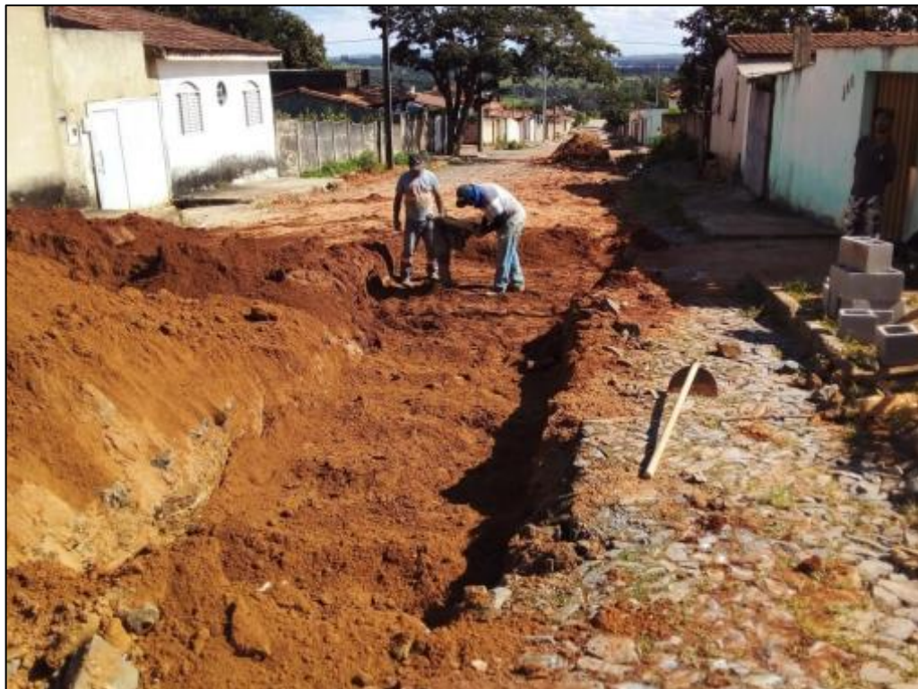
Figura 112 – Compactação mecânica da vala após manilhamento. Fonte: Relatório fotográfico.
