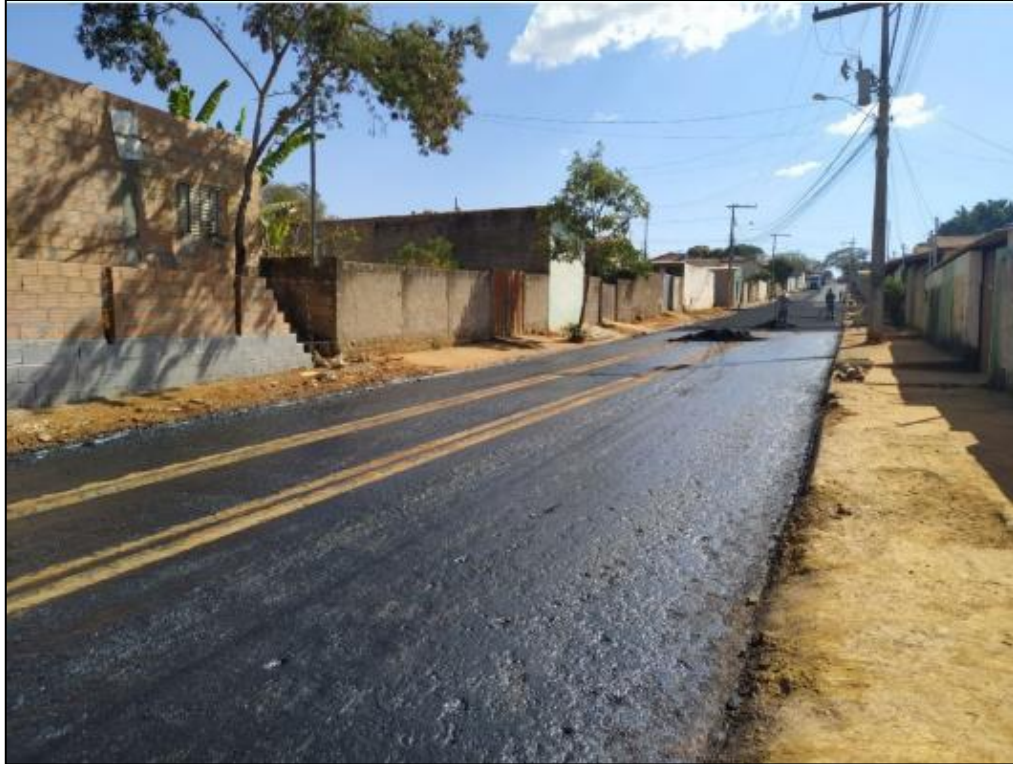
Figura 120 – Imprimação da Rua Corinto. Fonte: Relatório Fotográfico.
